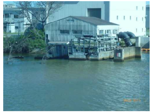
△地盤沈下と水害の現状
